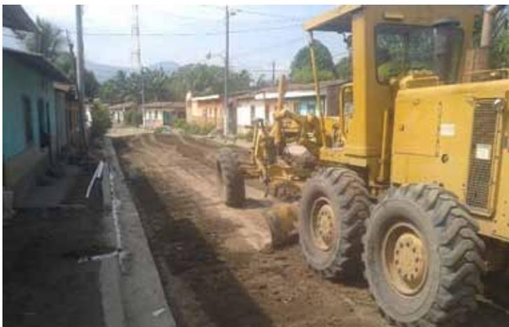
Obras preparatorias para la pavimentación de los accesos principales
