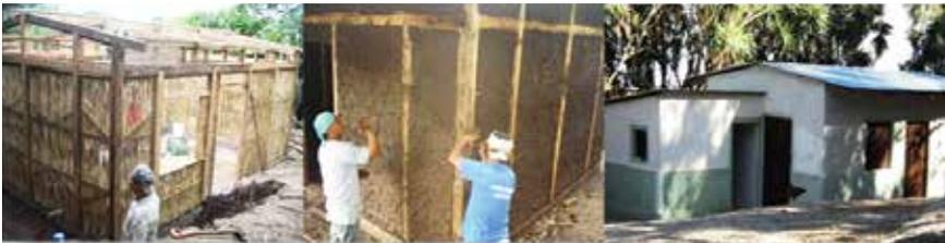
Fotos: Proceso constructivo de vivienda nueva (Sistema Quincha Prefabricada)
