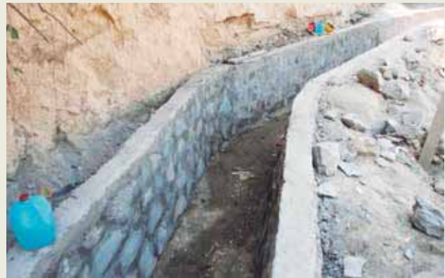
Canaleta para encause de aguas lluvias –servidas
