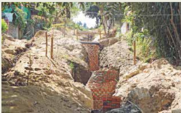
Infraestructura para la evacuación de aguas negras en comunidad Montecarmelo, Soyapango.
