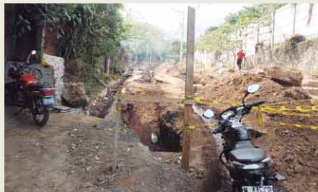
Trabajos para la instalación de tuberías para la evacuación de aguas negras, comunidad El Milagro, Mejicanos.
