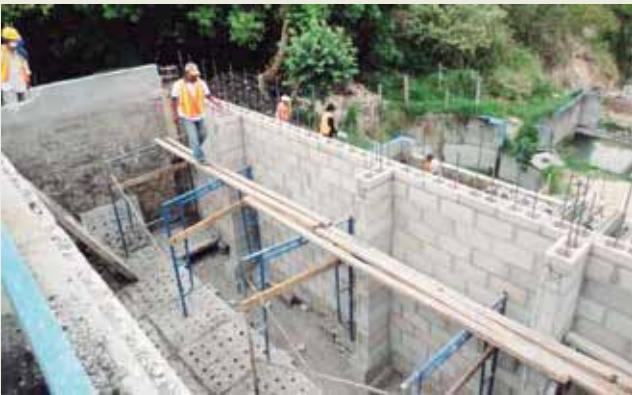
Etapa constructiva del filtro percolador 1 en la Planta San Fco. Comunidad San Carlos y Las Margaritas, Soyapango.
