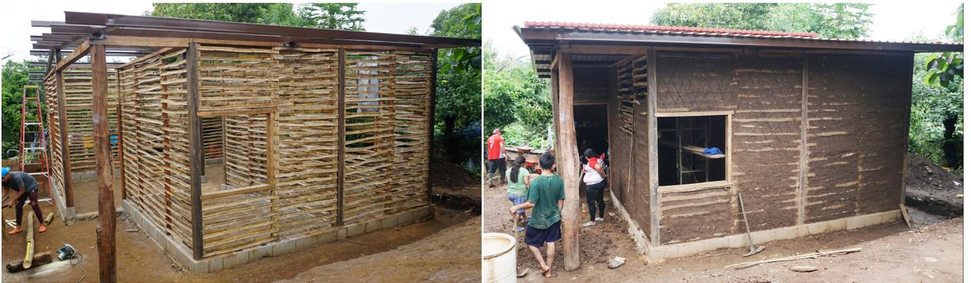
**Figura 7.** Proceso constructivo de vivienda de Bersaides con el sistema constructivo Bahareque Mejorado. Izquierda: envarillado con vara de bambú; derecha: proceso de embarre de vivienda. (crédito: S. Pintera - FUNDASAL)
