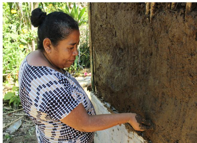
**Figura 2.** Proceso de construcción de letrinas aboneras (Crédito: S. Pineda - FUNDASAL)
