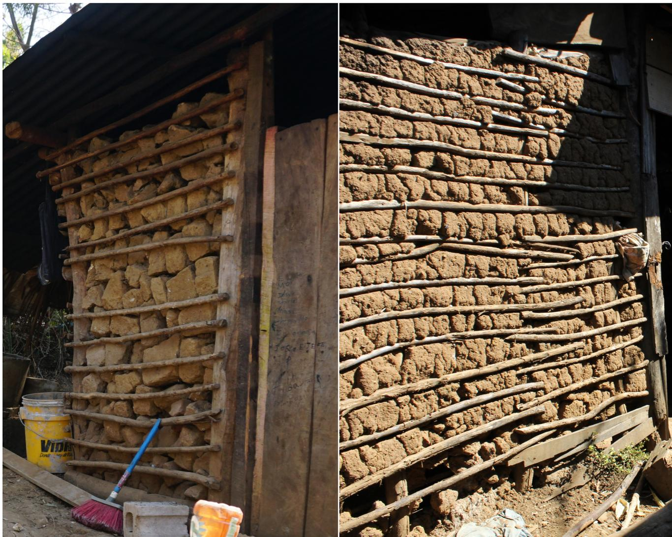
**Figura 6.** Viviendas existentes en Potrerillos, Alegría. Izquierda: relleno de pared con "terron" y piedra; derecha: bahareque con varas de árbol de Tigüilote. (crédito: T. Juárez - FUNDASAL)
