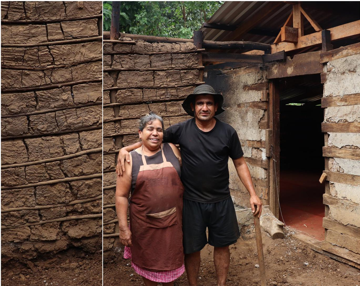
**Figura 5.** Izquierda: Base de pared de bahareque; derecha: Para el envarillado también se han encontrado prácticas de utilización de tablas de madera aserrada. (crédito: T. Juárez - FUNDASAL)
