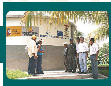
Tanque de almacenamiento de agua.
