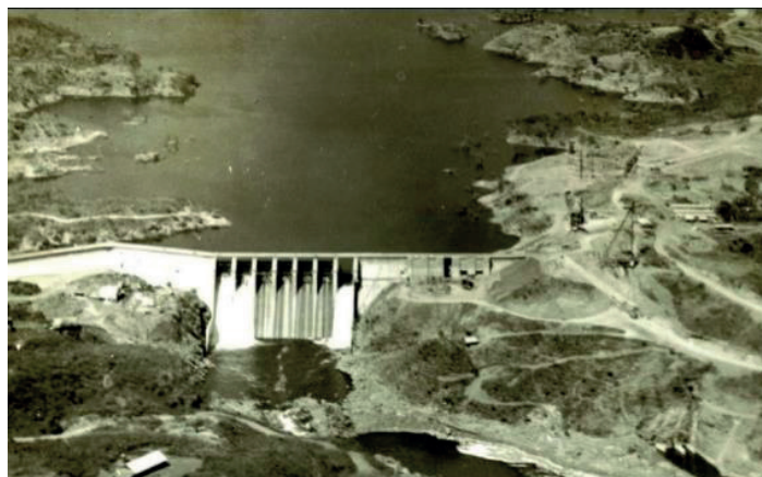
Figura 21. Construcción de la Presa 5 de Noviembre. Fuente: Presentación por Manuel Escobar de la Comisión Ejecutiva Hidroeléctrica del Río Lempa (CEL).
