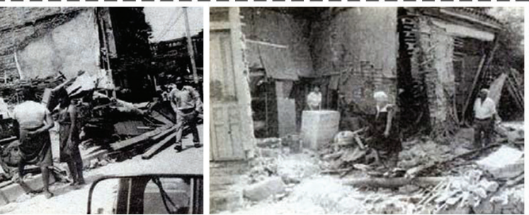
BARRIO LA VEGA: Fue uno de los barrios más golpeados por el sismo. Muchos de los edificios que originalmente eran de bahareque, cedieron ante el movimiento.
