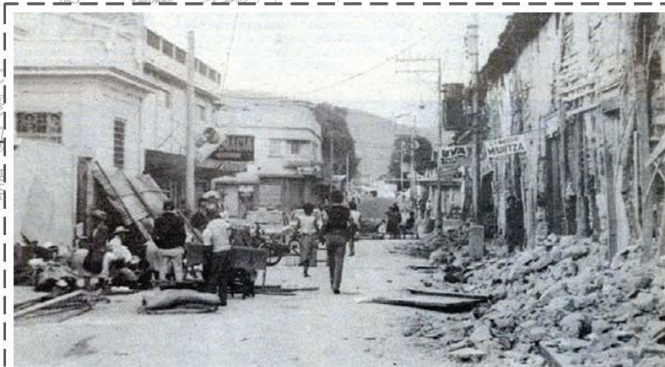
BARRIO CONCEPCIÓN: Daños en el recubrimiento de una vivienda de bahareque, contrastante con la inmutabilidad de las viviendas de concreto al frente.
