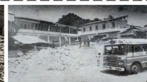
COLEGIO SANTA CATALINA: Fue uno de los casos más impactantes de la destrucción que dejó el terremoto, pues sus víctimas fueron niños. Mala aplicación y combinación de sistemas constructivos pudieron haber causado el fallo.
