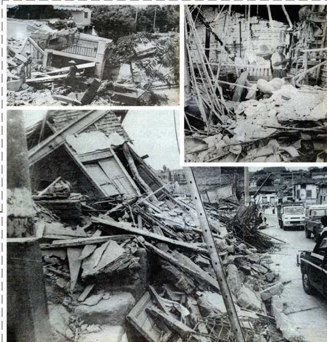
BARRIO SAN JACINTO: Fue uno de los más afectados. La mayor parte de San Jacinto estaba conformado por viviendas de bahareque, las cuales no resistieron al movimiento telúrico. De igual forma, algunas viviendas de concreto cedieron.
