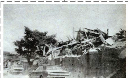
BARRIO LA VEGA: Al igual que en otros sectores, las viviendas de tierra resultaron como las estructuras con más daños.
