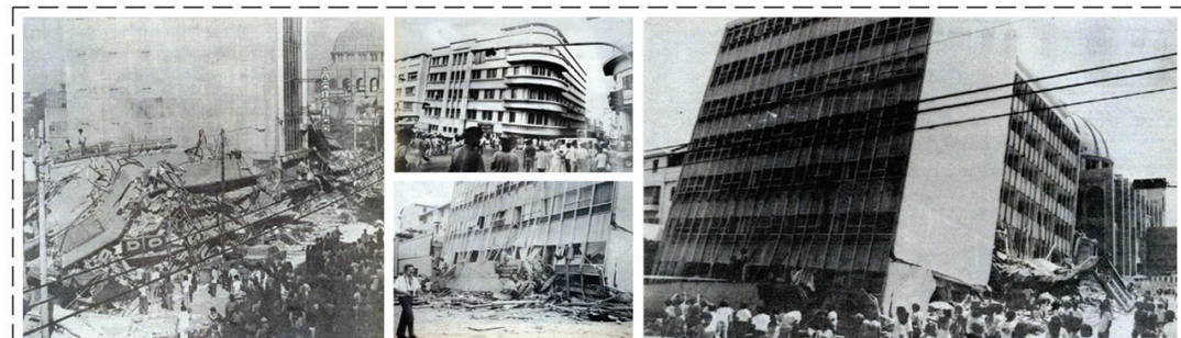
Daños causados al edificio de concreto Rubén Darío, el edificio Dueñas derrumbado el primer nivel completamente y el Gran Hotel de San Salvador.
