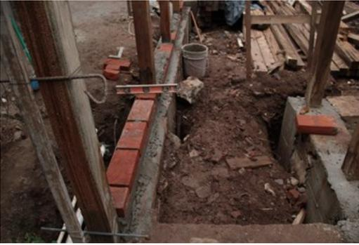
Parte del proceso constructivo del hospedaje: en la imagen de la izquierda, se ve la colocación de ladrillos de barro, que son el pretil donde se apoyarán los paneles prefabricados, además se visualizan las columnas de madera que contendrán los paneles; en la imagen de la derecha, se visualiza la estructura de madera del sistema.
