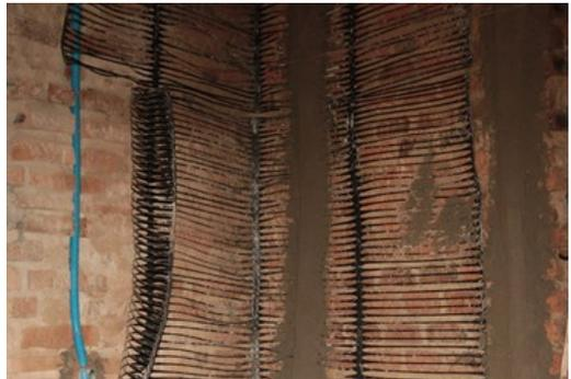
Vista de la malla uniaxial (en color negro), colocada en las esquinas de las paredes, para reforzar la estructura.
