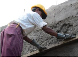
Luego del azotado del mortero, se realizó el codaleado para emparejar la pared.
