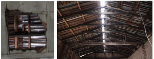
Estructura de madera, perteneciente a la cubierta original del edificio, antes de ser cambiada.
