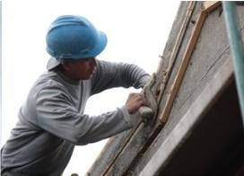
Con apoyo de piezas de madera, se reprodujeron las molduras del parapeto del edificio.
