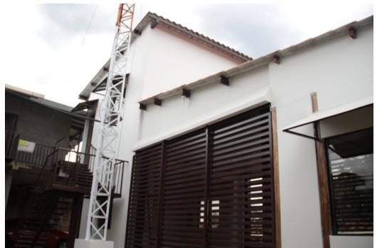
Diferentes perspectivas del hospedaje: La foto de la izquierda muestra las gradas, el cerramiento con celosía metálica para la sala común y al fondo se encuentra el módulo de quincha repellado y pintado; en la segunda fotografía se muestra un primer acercamiento a la sala común con su cerramiento, y al fondo se observa el módulo con los dos niveles.
