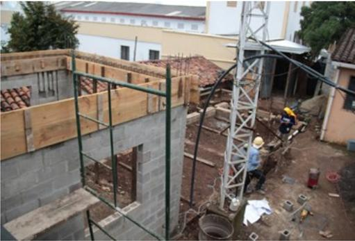
Construcción del módulo de bloque de concreto, que tendrá dos habitaciones distribuidas en dos niveles.
