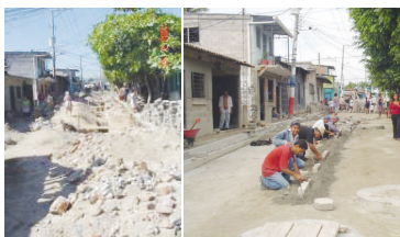
Mejoramiento de calles.
