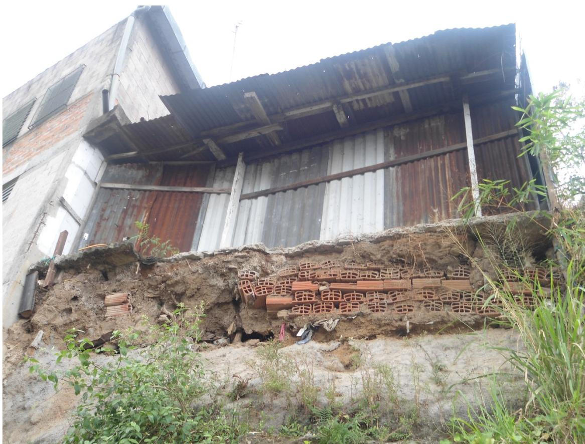
*Figura 21.* Vivienda precaria de un asentamiento urbano de Mejicanos. Nótese los esfuerzos por estabilizar el terreno que ha cedido, a pesar de la estructura liviana de la vivienda
