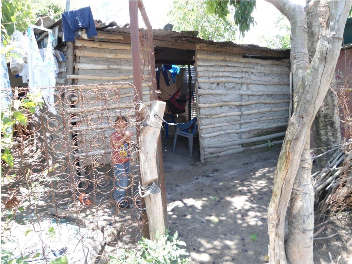
*Figura 8.* Vivienda de tierra y caña de bambú, situada en la zona urbana de Tonacatepeque, San Salvador. Obsérvese el cerco, hecho de troncos y un entramado de resortes, residuo de un colchón desvencijado.
