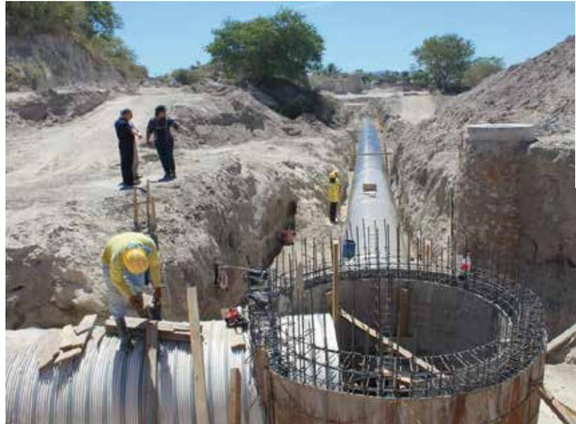
Instalación de tuberías y colector de aguas lluvias
