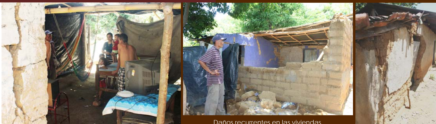
Daños recurrentes en las viviendas
