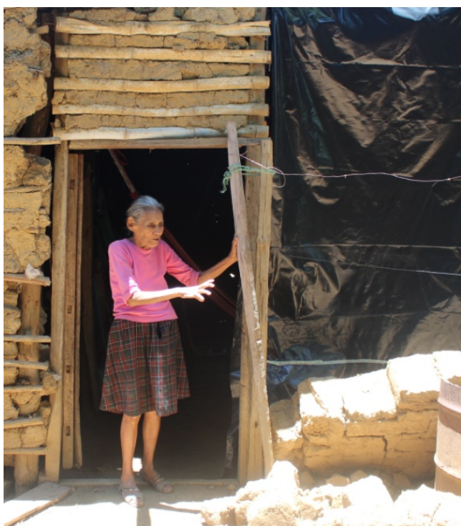
Tipo y materiales de las viviendas afectadas por el movimiento sísmico recurrente. Las paredes de adobe colapsadas han sido sustituidas por las "paredes de plástico".
