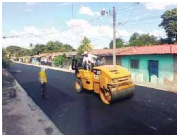
Compactado de concreto asfáltico en Colonias Las Brisas
