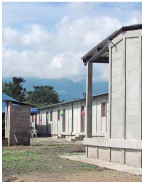
Viviendas tipo elevadas para prevenir inundaciones
