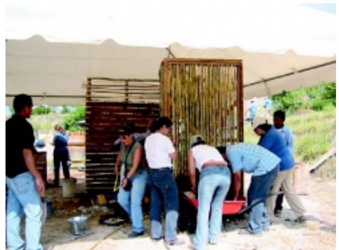
Asistentes aplicando una de las tecnologías propuestas de construcción con tierra, en el Centro de Producción de Materiales Alternativos (CPM) de FUNDASAL.
