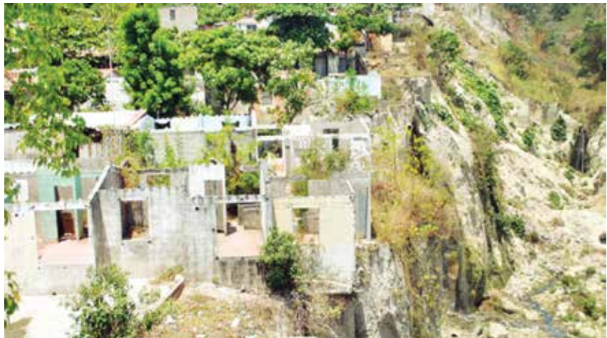
Viviendas de la Urbanización La Campanera en Soyapango, afectadas por Cárcava siendo evacuadas 48 familias en abril 2012.
