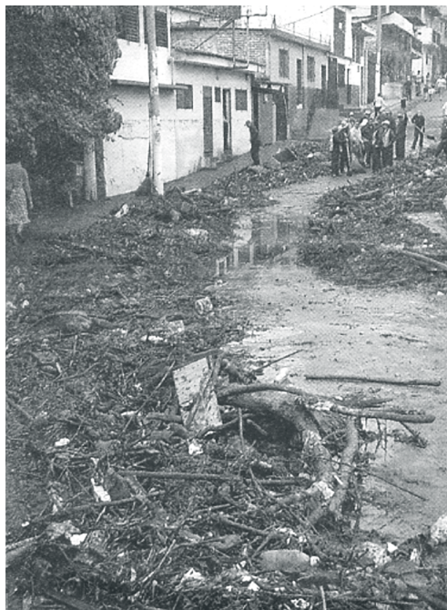
Foto No. 2 Estragos por lluvias en el Barrio Candelaria, mayo 2005.
