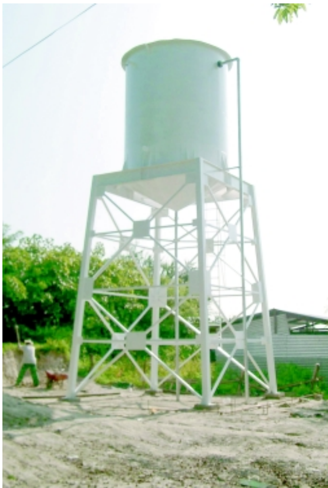
Tanque de almacenamiento de agua en Cantón El Paredón, San Pedro Masahuat
