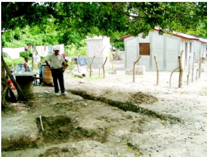
Zanja en construcción de la Red de distribución de Agua Potable en Comunidad Nueva, San Rafael Obrajuelo
