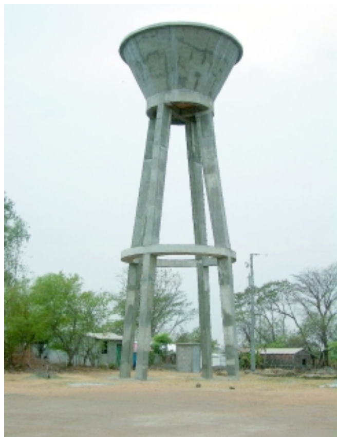
Tanque de almacenamiento de agua en Cantón Concepción Jalponga, Santiago Nonualco
