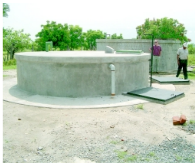
Tanque de almacenamiento de agua en Cantón Nahualapa, El Rosario
