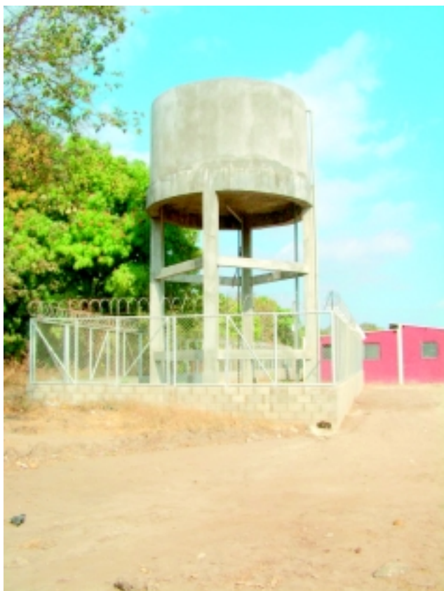
Tanque de almacenamiento de agua en Comunidad La Esperanza, Zacatecoluca
