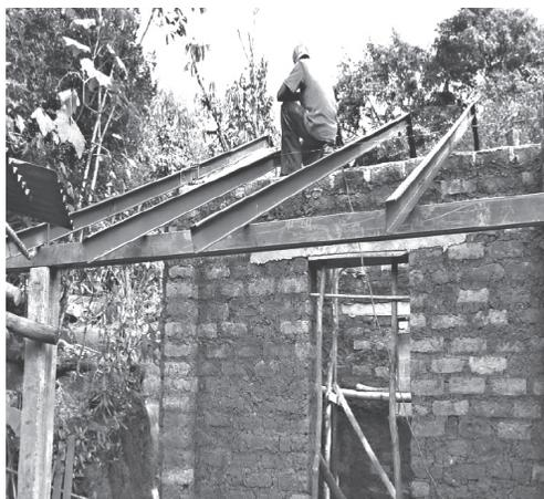
*Instalación de la estructura del techo en una de las viviendas construidas en Ciudad Barrios.*
