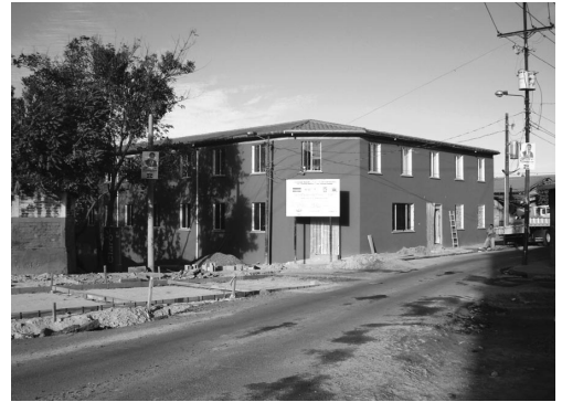
Fachada principal del condominio.
